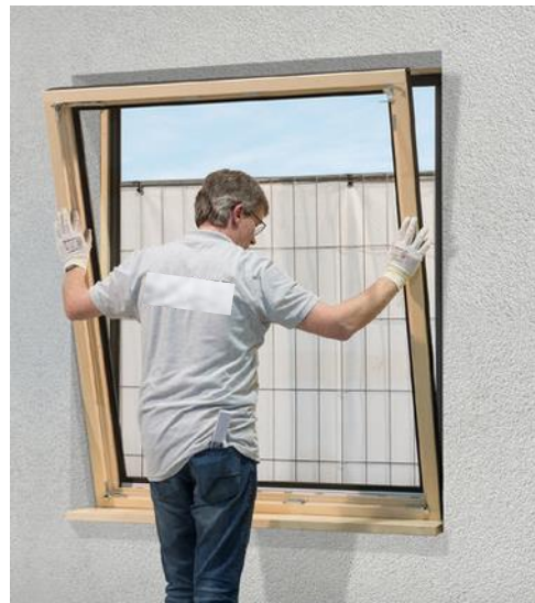
Bild 10 Fenstereinbau in 2 Schritten: 1. Schritt Rohbaumontage (Vorab-Montagezarge, links) und 2. Schritt Endmontage (Fenster, rechts) (Quelle: Fa. Döpfner Betriebs GmbH & Co. KG)
