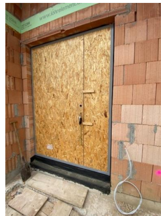
Bild 11 Temporärer Verschluss mit Lattenrahmen und Folie (links) oder mit Bauplatten, offenbar als Bautür (rechts) (Quelle: Fa. Finstral AG)
