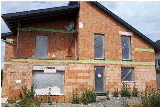
Bild 11 Temporärer Verschluss mit Lattenrahmen und Folie (links) oder mit Bauplatten, offenbar als Bautür (rechts) (Quelle: Fa. Finstral AG)
