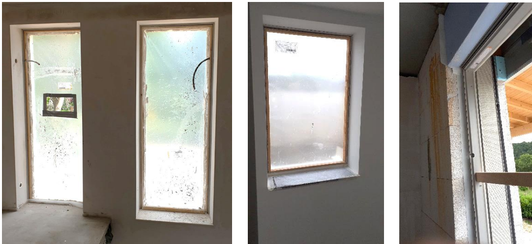
Bild 13 Zargenkonstruktion ermöglicht fachgerechten Anschluss und Ausführung der angrenzenden Gewerke (z. B. Estrich, Putz, Fensterbank, Sonnenschutz) (Quelle: Finstral AG)
